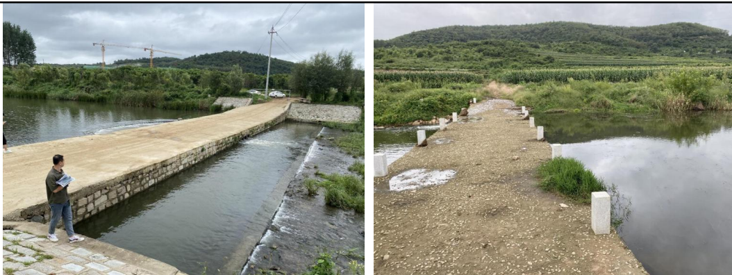
昌阳河桩号 11+240、13+990 现状漫水桥
