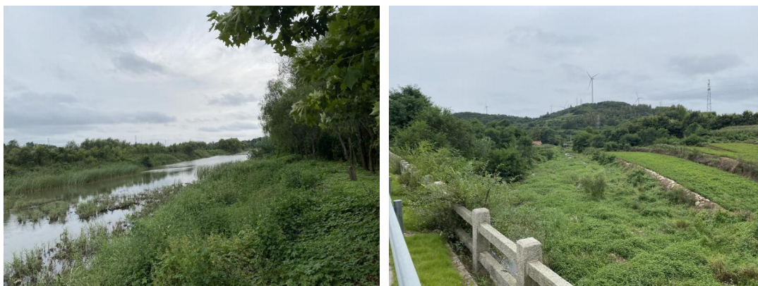
昌阳河现状河道杂草丛生、淤积严重
