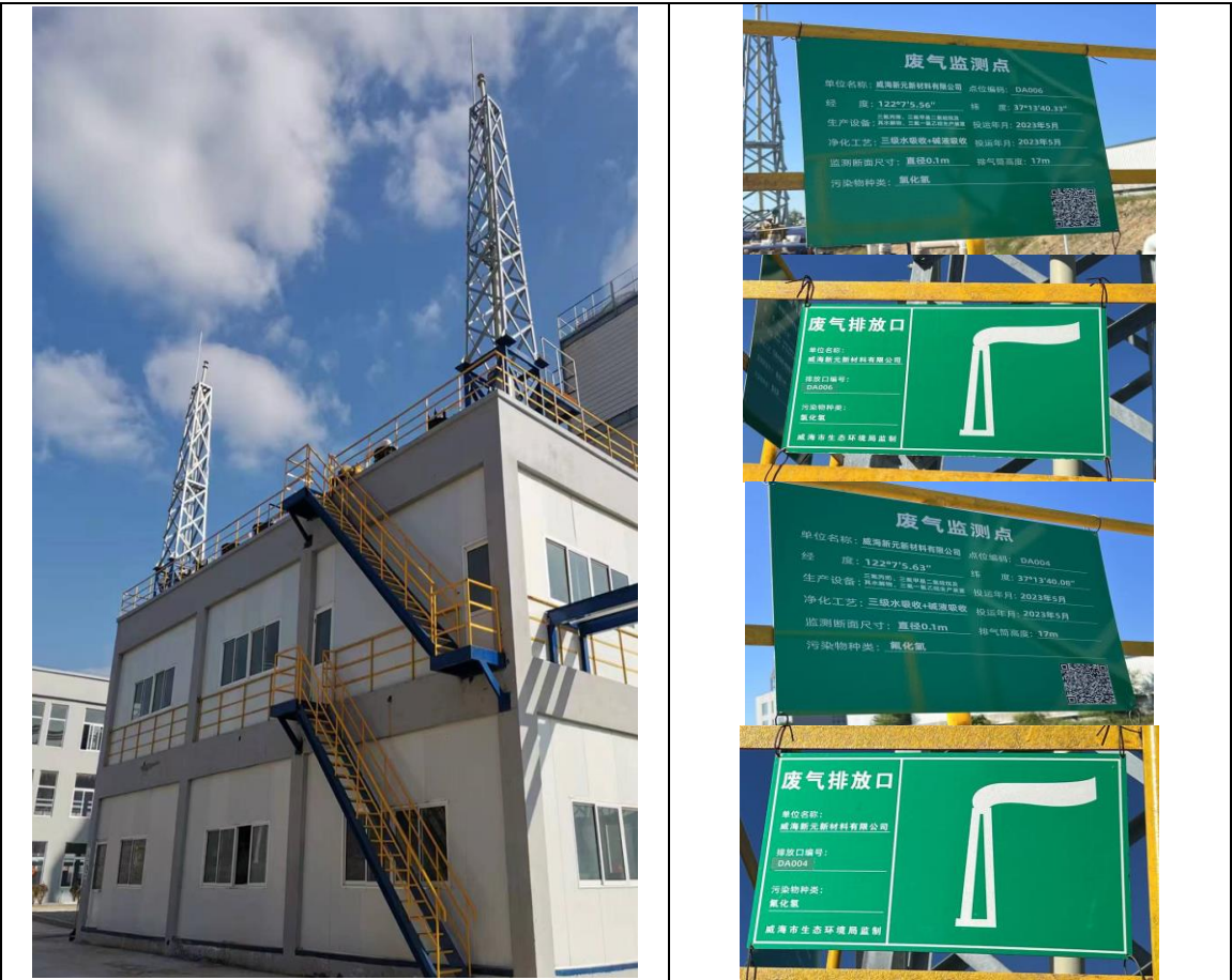
9#车间 DA006(左)和 DA004(右)废气治理设施
